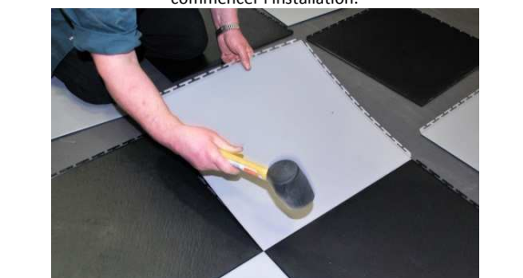
Pic 5. Ne forcez les tuiles, offrent jusqu'à l'angle de la tuile et doucement marteler les joints ensemble.
