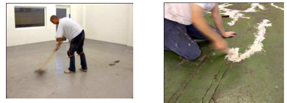
Pic 2. Balayer le plancher, enlever les points forts et de réparation patch ou le niveau des fissures ou des points faibles..
