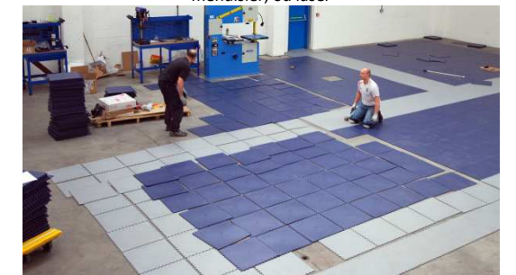
Pic 4. Diviser la palette et de répartir les tuiles sur le plancher avant de commencer l'installation.
