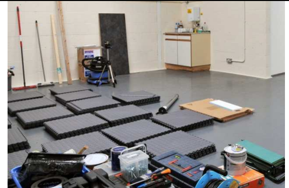
Pic 1. Décomposer les palettes et de permettre carreaux de s'acclimater
